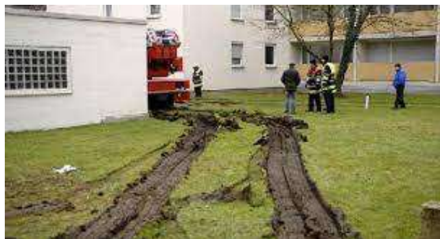
Abb. 12 – Spurrillen bei Schotterrasen [c]
