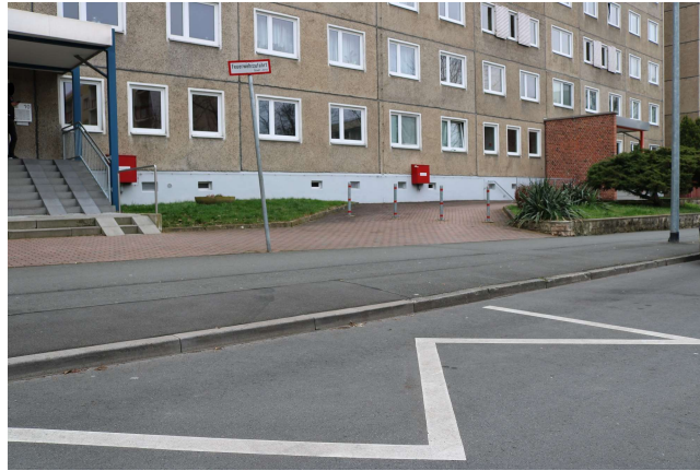
Abb. 20 – Parkstreifenunterbrechung im Bereich einer Feuerwehrezufahrt [c]
